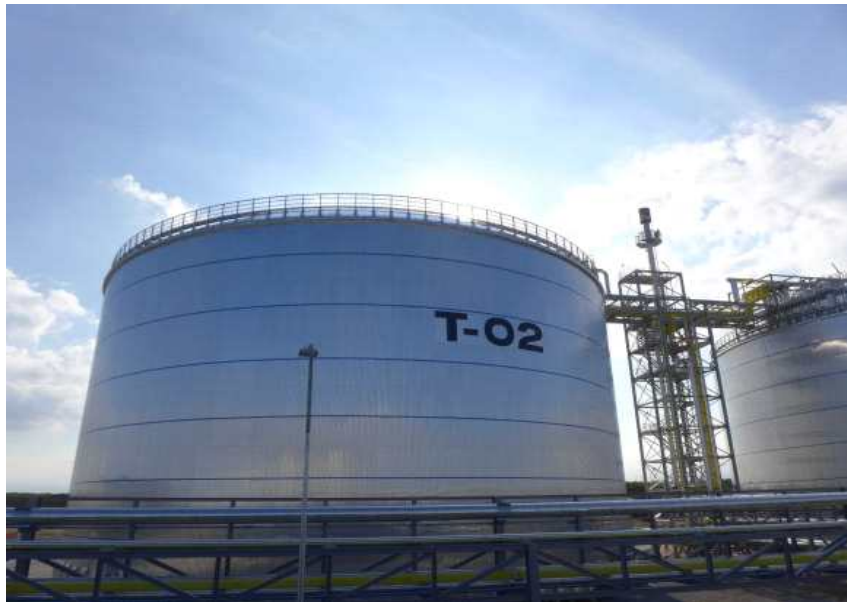
그림 13 암모니아 저장 탱크 <출처:Source: Proton Ventures.>
